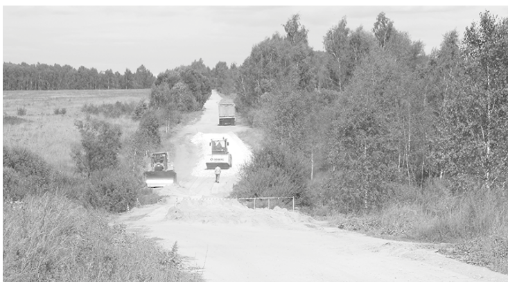
Ремонт дороги в д. Гурьево
