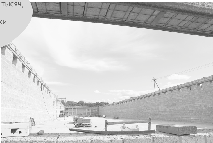
Возводится новый корпус для птиц
